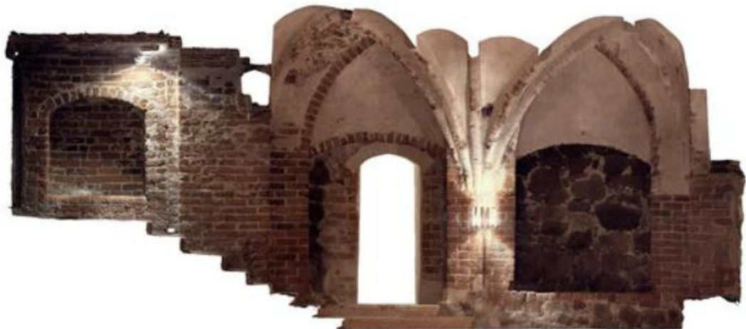
Joonis 1. Ajaloolise ehitusobjekti laserskaneerimispunktide pilve väljavõte koos fotografeeritud värviandmetega, Turun linnan herrainkellari, üks Turu muuseumikeskuse ruumidest. Joonis: Tietoa Finland Oy.
