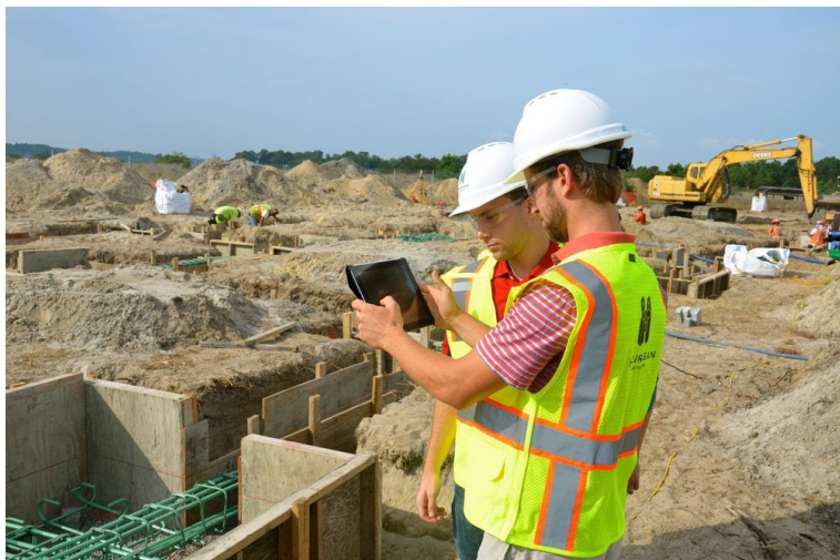
Joonis 7.12. Tudengid kasutamas Autodesk BIM 360 tarkvara (iPad platvormil), et kontrollida vundamenti talade (ingl grade beam) paigutust (allikas: Virginia Tech).
